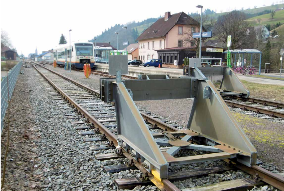
Für den täglichen Betrieb genügt das Bahnsteiggleis: Oberharmersbach-Riersbach.
